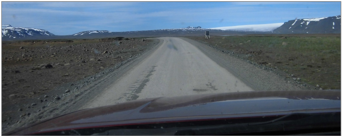
Mynd 11. Framkvæmdakaflann sunnan Árbúða um miðjan júlí árið 2018 þegar lagfærinum á veginum er lokið (Ljósmynd: Guðmundur Guðbrandsson).
