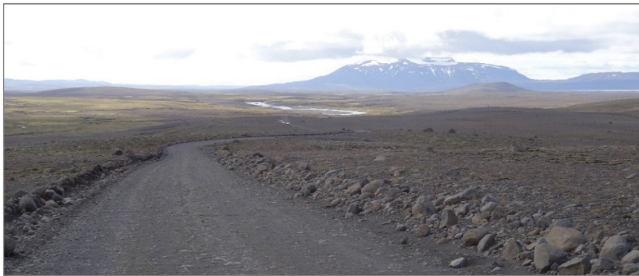
Mynd 4. Kjalvegur á fyrirhuguðum framkvæmdakafla (HA, ágúst 2018).
